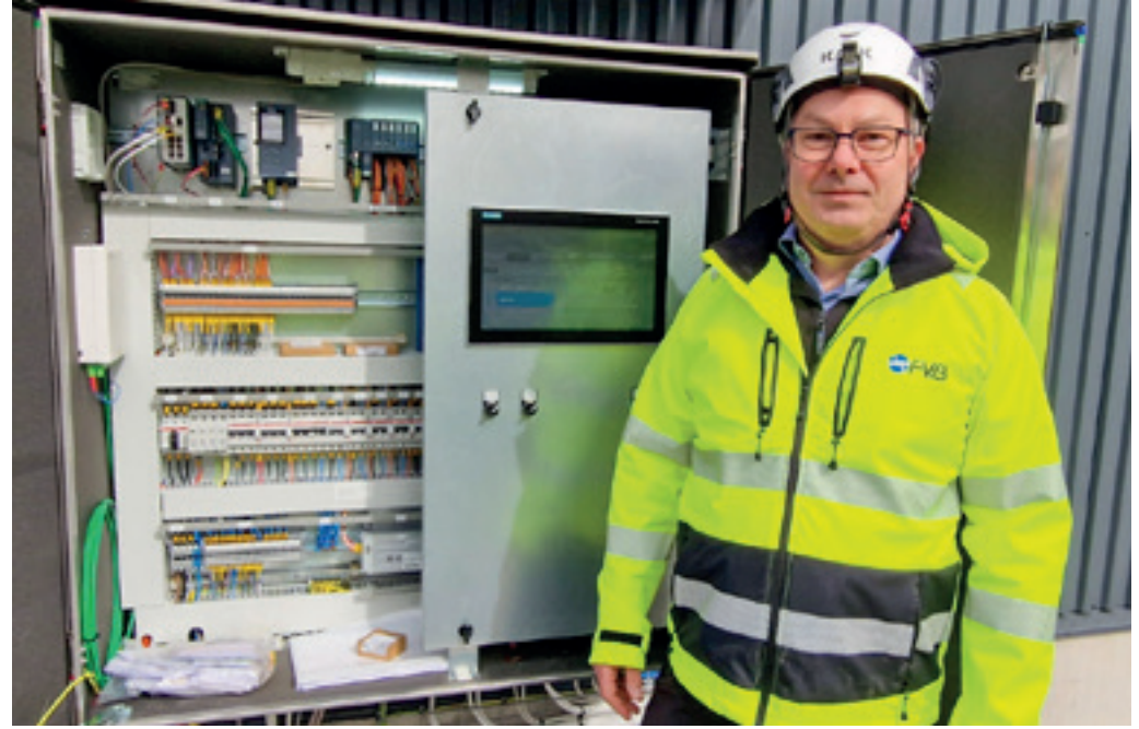
Nytt styrskåp till kolkällan där etanol används till att reducera kvävet i befintlig MBBR (Moving Bed Biofilm Reactor) innan det går vidare ut i våtmarken.
