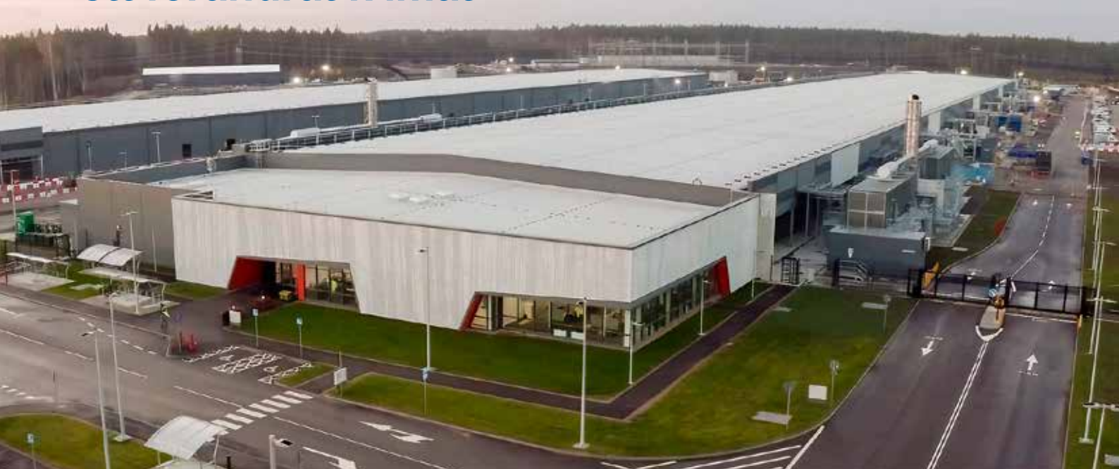
I Gävle ska Microsoft bygga fler datahallar och de byggs för att klara kraftiga översvämningar. Bild från Microsoft.
