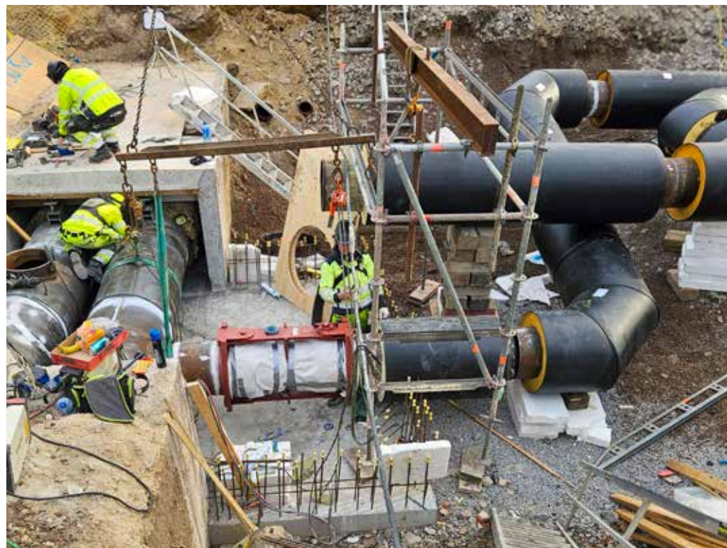
En komplex inkoppling av DN500/800 på DN800 betongkulkvert och på grund av närhet till en 130kV elledning krävdes en omprojektering.
