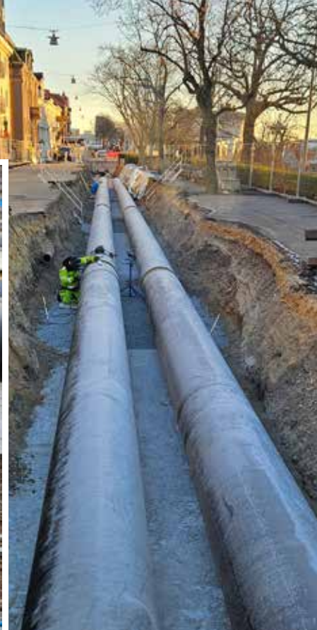
En komplex inkoppling av DN500/800 på DN800 betongkulkvert och på grund av närhet till en 130kV elledning krävdes en omprojektering.
