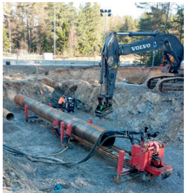
Det är kraftfull utrustning som krävs för att få ett metallrör med ytterdiametern 900 mm genom berg. Den längsta sträckan genom berg är 64 meter.
