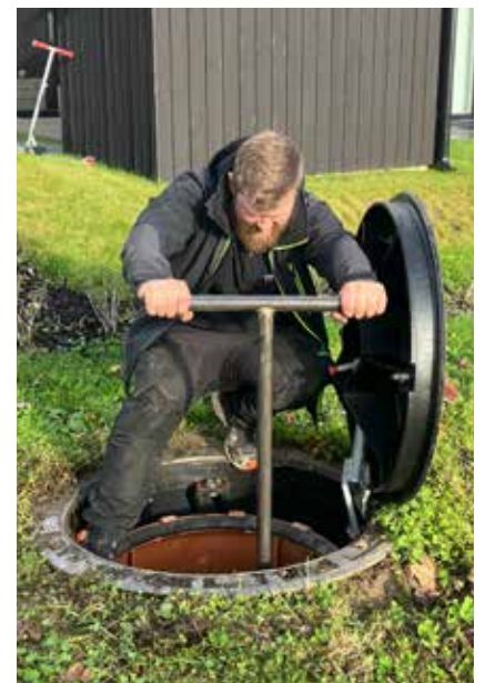
Drifttekniker Tobias Uddemar öppnar markventilen vid driftsömläggningen.
