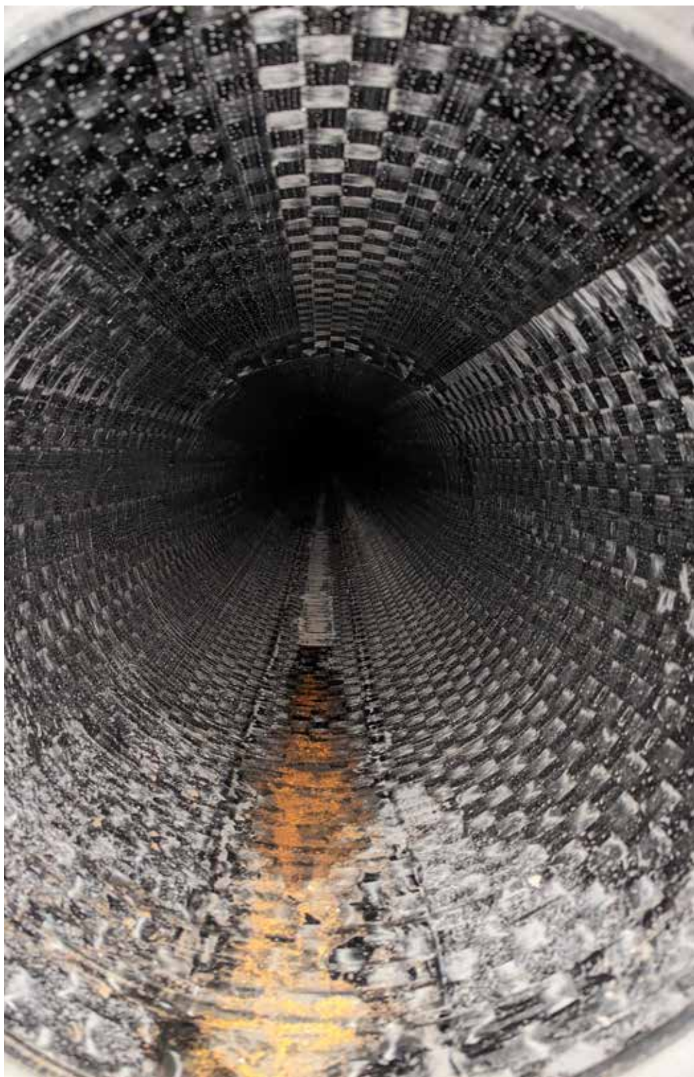
Efter installation ser insidan av det relinade röret ut så här. Den platta linern har blivit hård efter härdning och är nu redo för drifttagning. (Foto: Dennis Hild-Walett).
