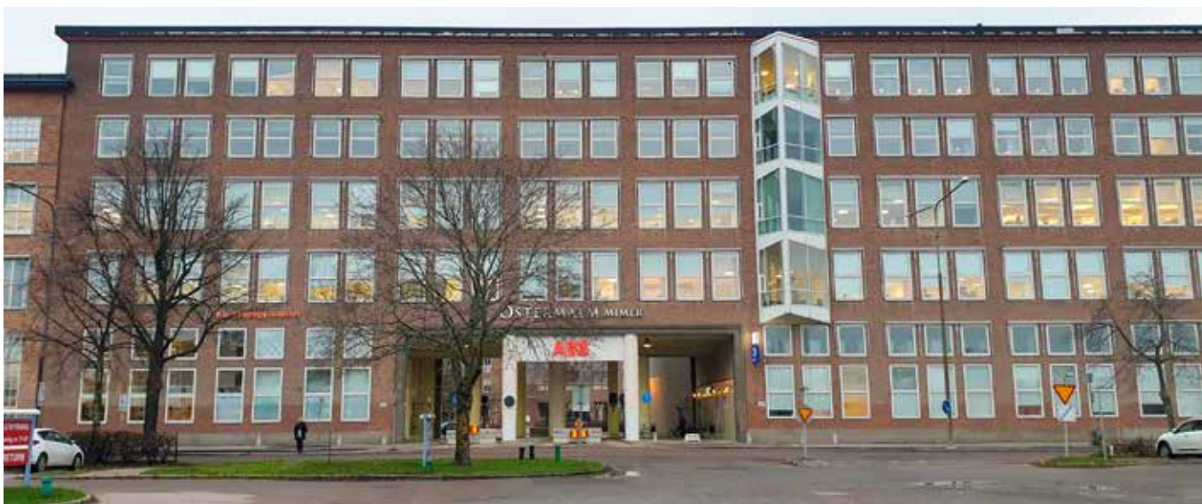
Den första fjärrkylakunden var ABBs gamla industrivarter – Mimer – i Västerås, vilket byggdes om till kontor. Så här ser byggnaden ut idag. (Foto: Samuel Bjurhager).
