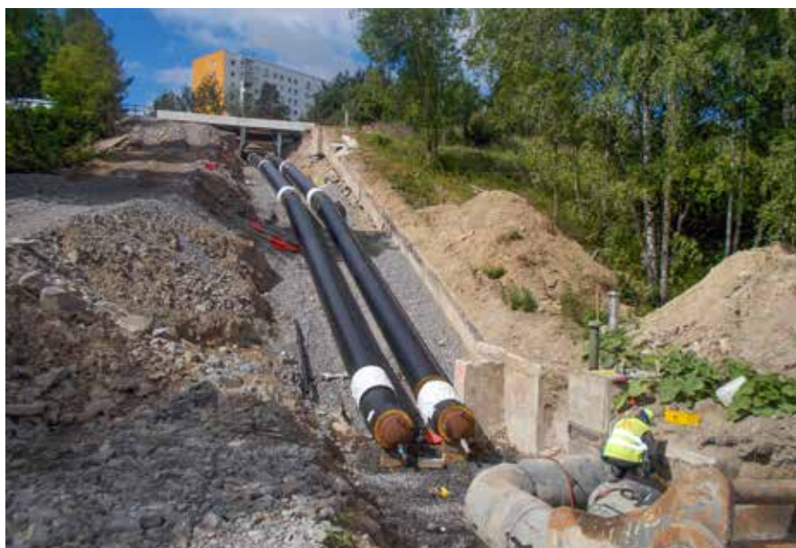
FVB projekterade fjärrvärmeledningen vid Ebba Bååts väg i Flemingsberg, Huddinge. (Foto: SFAB).
