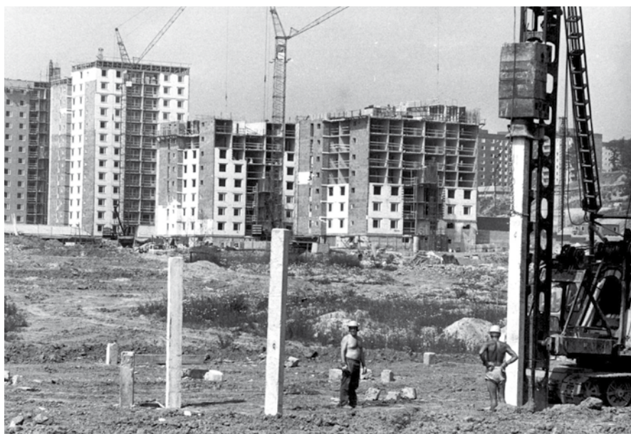
FVB var med redan när SFABs första kunder – flerbostadshus i miljonprogrammet – fick fjärrvärme.
