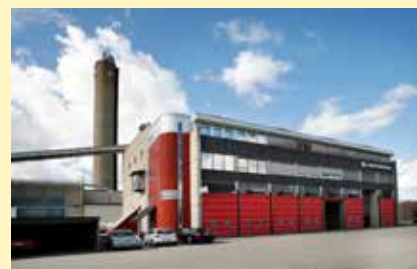
Ålidhems Värmeverk. (Foto: Johan Gunséus).
