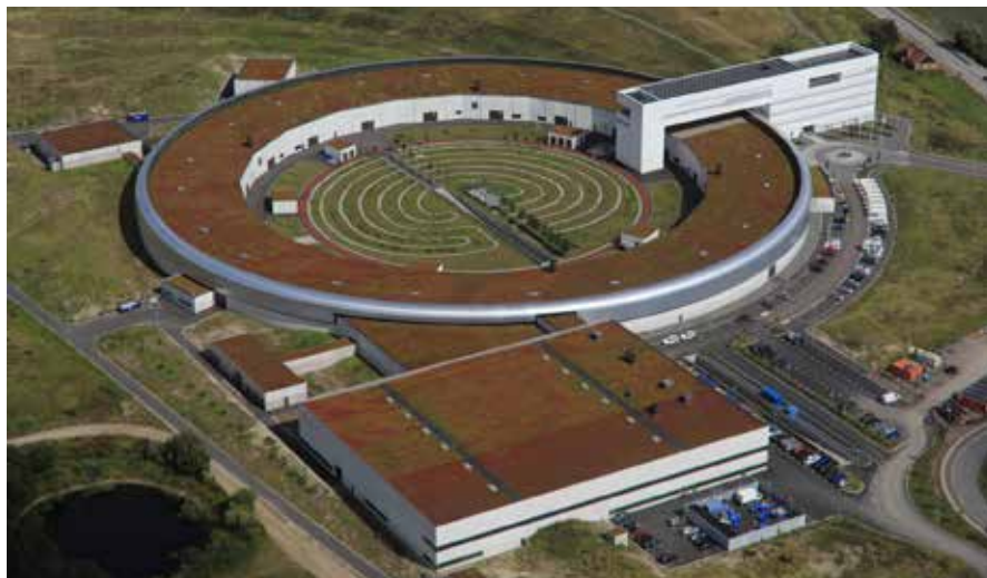
Restvärmen från forskningslaboratoriet MAX IV ger fjärrvärme via lågtemperatursystem.
