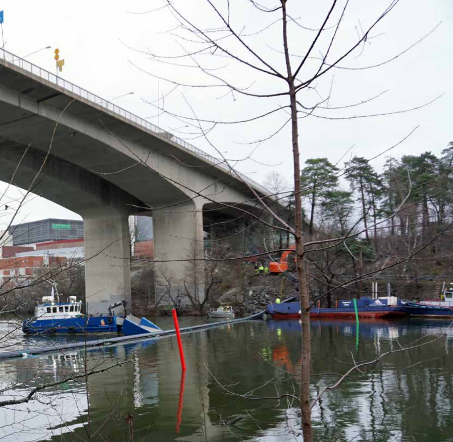
Sjöförläggning av fjärrkylrör över Bällstaviken. Två PE-rör DN 600 på vardera 103 meter sänktes ner på botten. (Foto: Norrenergi).
