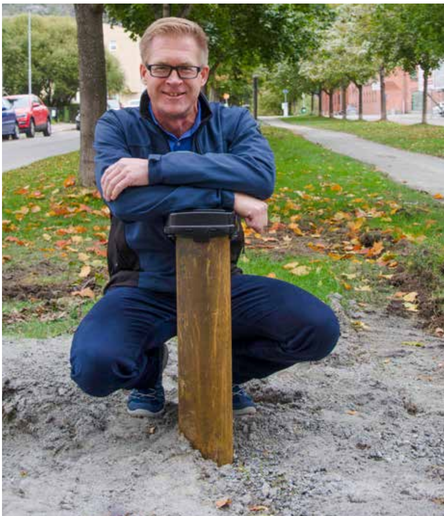
På Västra allén har projektledaren Thomas Nordin ett kylalager under fötterna i form av vatten från Sundsvallsåsen.
