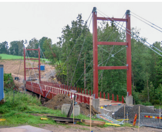
Passagen vid Hälltorpsdammen där en bro byggdes 2004 för att hänga befintliga fjärrvärmeledningar under.
