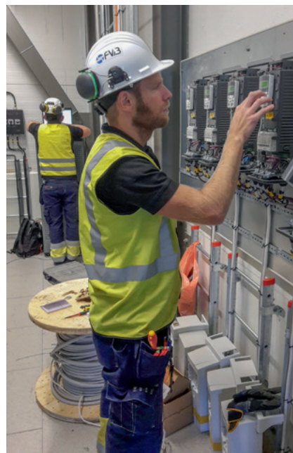
Benny Cedervång från FVB konfigurerar ABB frekvensomformare.
