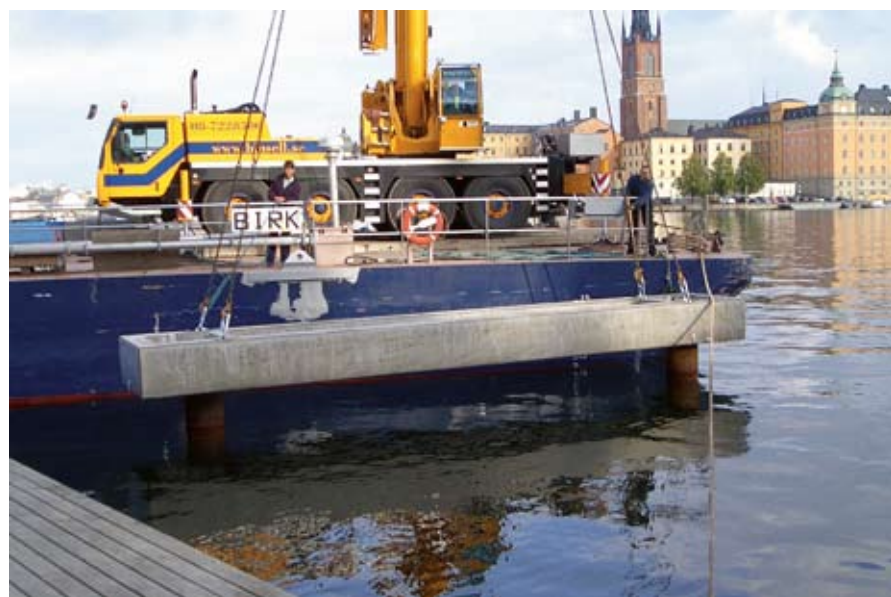
Riddarfjärdens botten är på vissa ställen extremt lös så på dessa ställen fick lösningen bli att sänka ner betongstöd för ledningarna att vila på.
