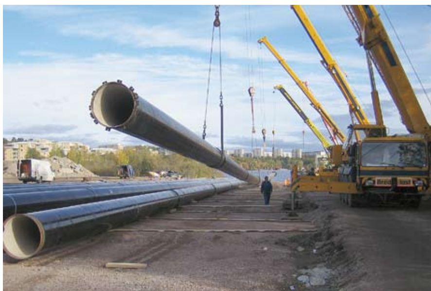
Rören har levererats i längder på 16 meter med fram- och returledning. Svetsarbetet sker med fördel på land och större längder har svetsats samman i Ulvsunda vid Mälarens strand.
