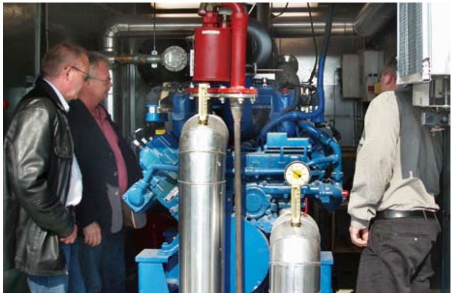
Kjell Wigander, driftansvarig på Borlänge reningsverk och Leif Johansson, projektledare på Borlänge Energi, studerar en liknande biogasmotor som ska ge 230 kW el i Borlänge Energis nya kraftvärmeanläggning.
