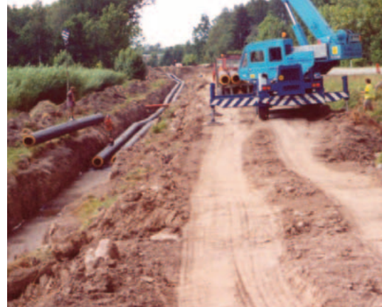
Arbetet pågår för fullt med den 17 km långa transiteringsledningen mellan Västerås och Hallstahammar.
