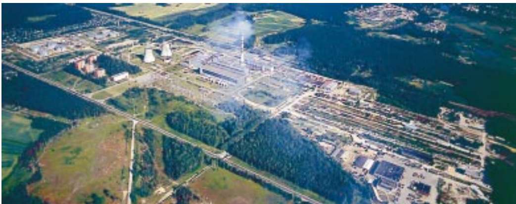
Huvudproduktionen kommer att ske i den stora kraftvärmeanläggningen TEC-2 och därmed kan elproduktionen på sikt öka med 400.000 MWh/år. Utsläppen av svavel, NOx och CO2 kommer att reduceras kraftigt.
