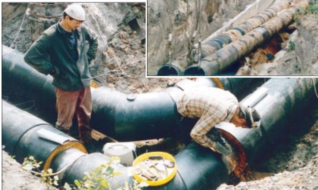
Nya, friska rör läggs. Totalt skall 19 km rör bytas ut samt 150 st fjärrvärmecentraler byggas om under 1997.
