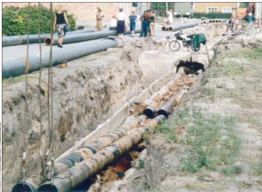
De gamla sönderrostade fjärrvärmerörerna har frilagts och lyfts upp.
