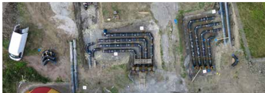
Förberedande arbeten vid anslutningspunkterna i respektive nät har påbörjats. På drönarbilderna syns inkopplingen av transiteringsledningen mot produktionsanläggningen i Arboga.
